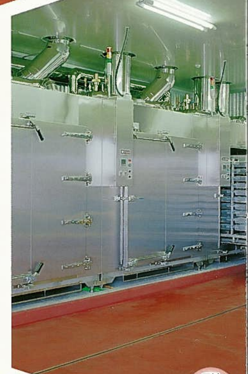
原料 急速凍結庫 (入荷バース内)
